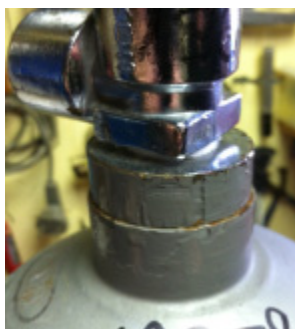
Afb. 15 Knutselen, kleinconisch in een 3/4" cilinder. De adapter is duurder om te maken dan de prijs van een nieuwe kraan....
